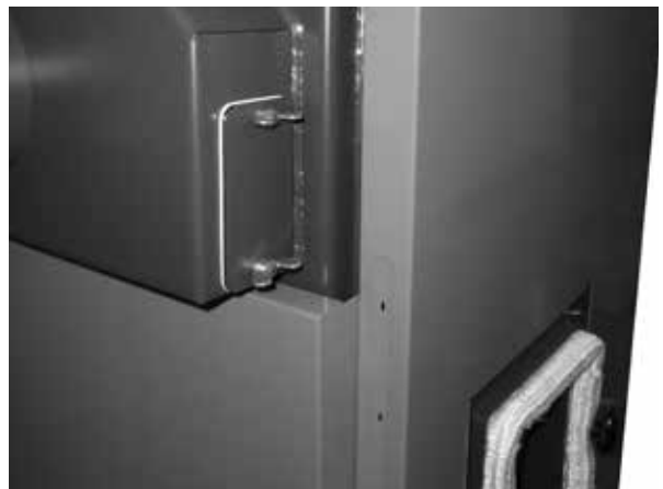
Connecteur sur la chaudière hotte gauche
