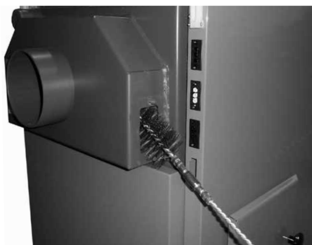
Nettoyage de la tuyauterie des fumées. Effectuez après le nettoyage de la plaque tubulaire dans la chambre de combustion de la chaudière.
