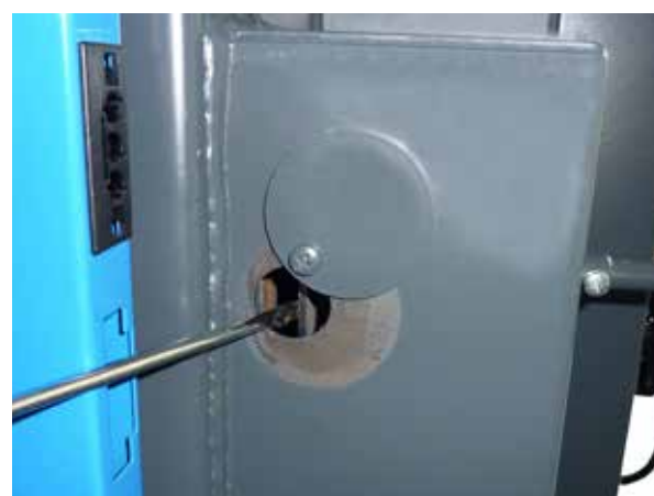
Contrôle et nettoyage de la régulation du rapport entre l'air primaire et l'air secondaire en utilisant l'orifice de nettoyage
