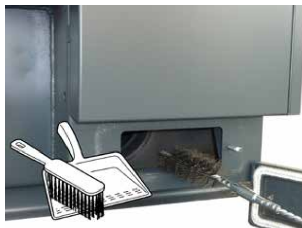
Nettoyage de la tuyauterie des fumées - couvercle inférieur
