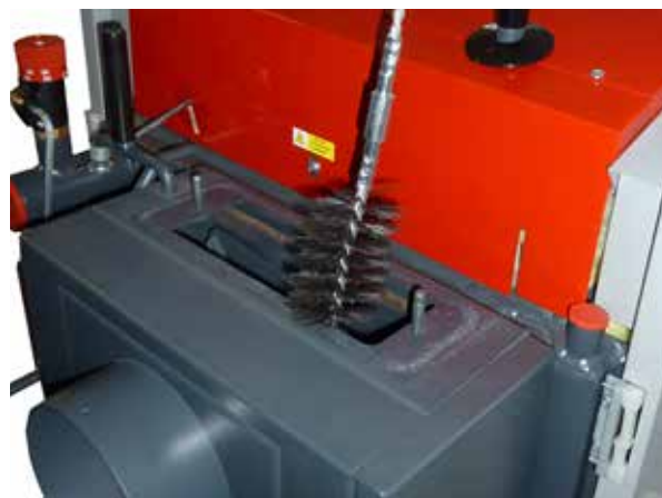
Nettoyage de la tuyauterie des fumées à l'aide d'une brosse en fer - couvercle supérieur
