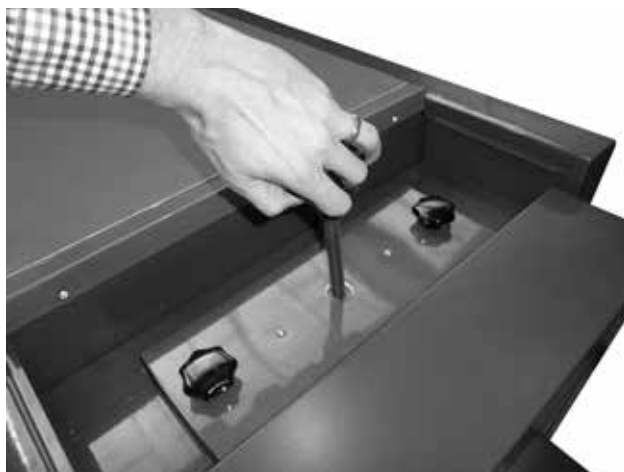
Exemple de nettoyage de l'échangeur tubulaire et des turbulateurs avec mouvement de montée et descente
