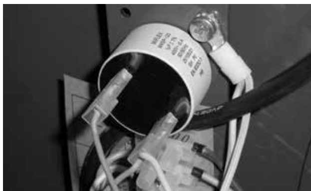
Emplacement du condensateur de démarrage (1 µF) du ventilateur extracteur (à l'exception D10PX)
