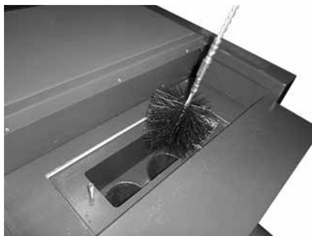
Nettoyage en profondeur de l'échangeur tubulaire avec la brosse
